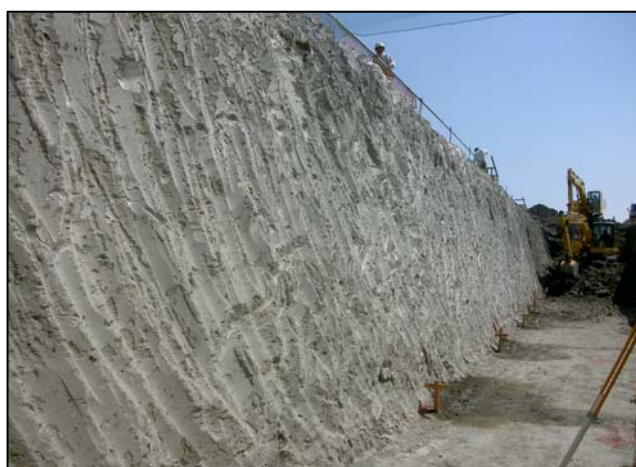
改良地盤 掘削断面
