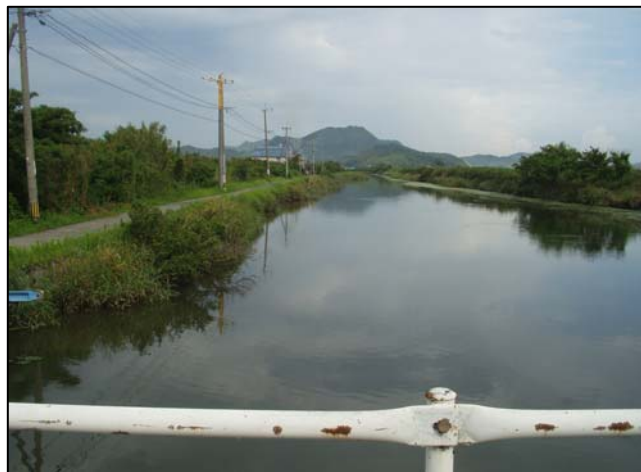
着工前 潮遊池 近景
