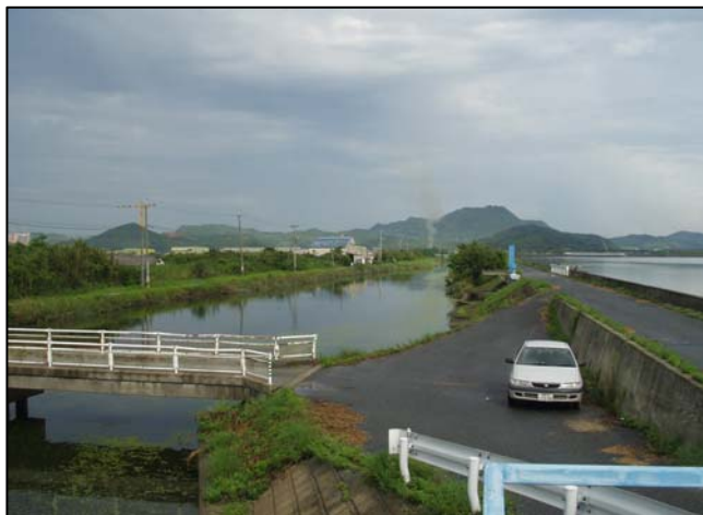
着工前 潮遊池 遠景
