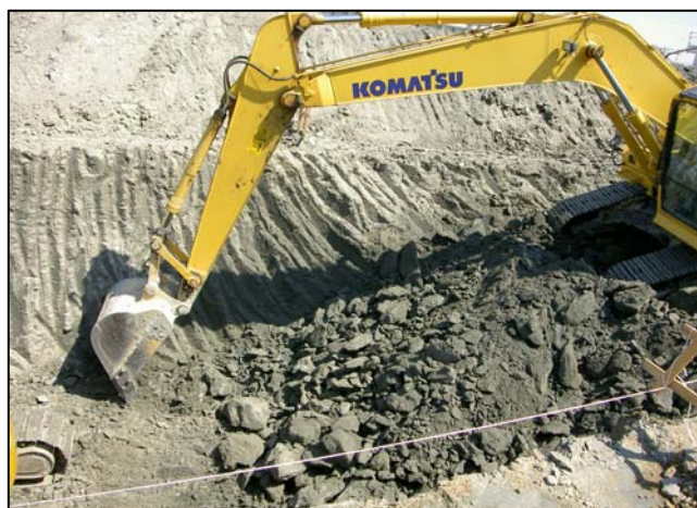
改良地盤 掘削中 近景
