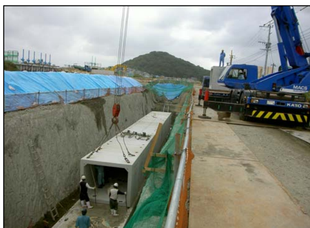
掘削断面中にカルバートボックス吊り込み中
