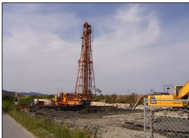
FD-20 2軸横行式改良機 施工中
